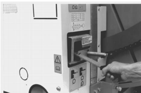
Le levier d'arrêt doit être en position „déroutement du tube PE“.
